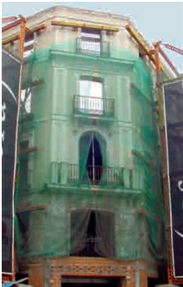
Vista actual de la Sede Colegial de la Calle Tetuán.
